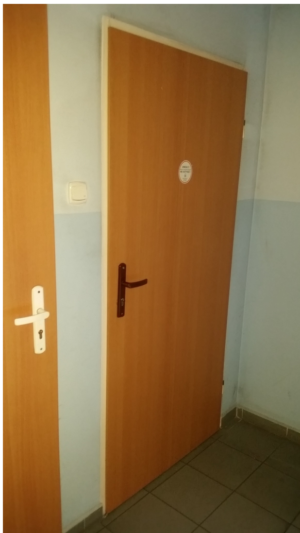
Widok od strony klatki schodowej
