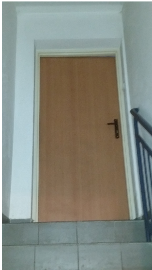
Widok od strony piwnicy
