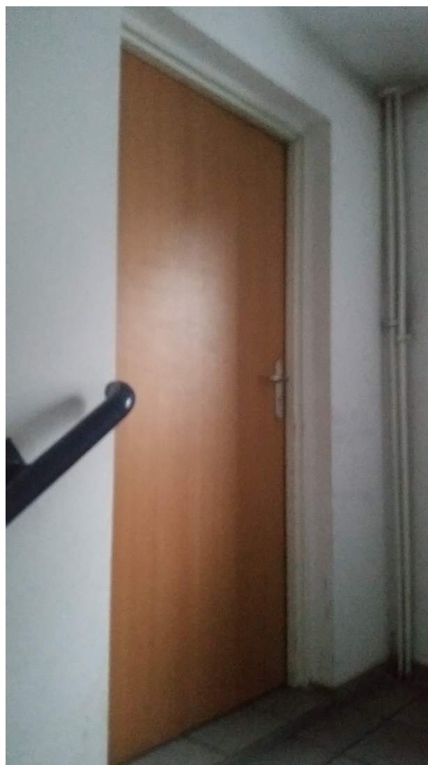
Widok od strony piwnicy
